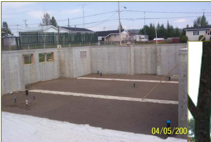
Début de la construction au 4 mai 2006
